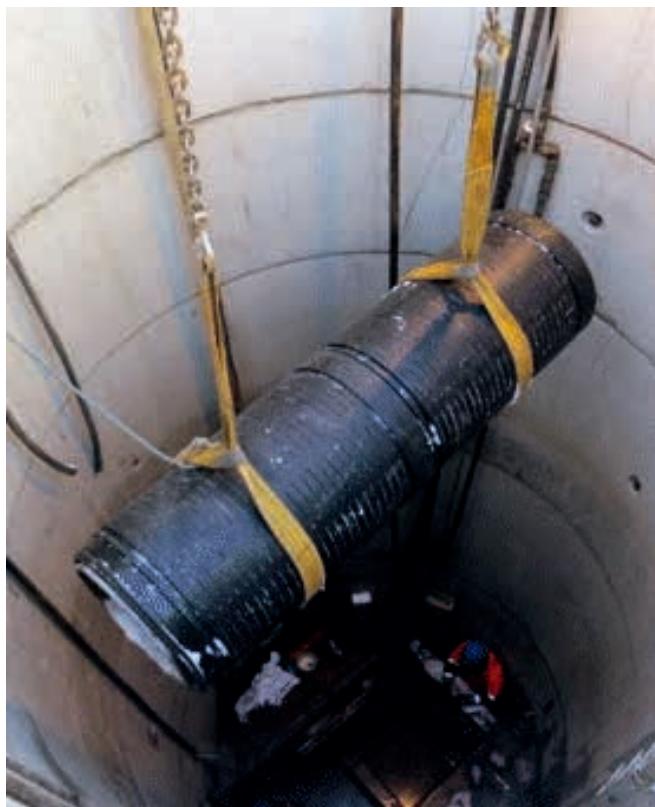
Ryc. 1. Opuszczanie VipLinaera do komory startowej [3]
