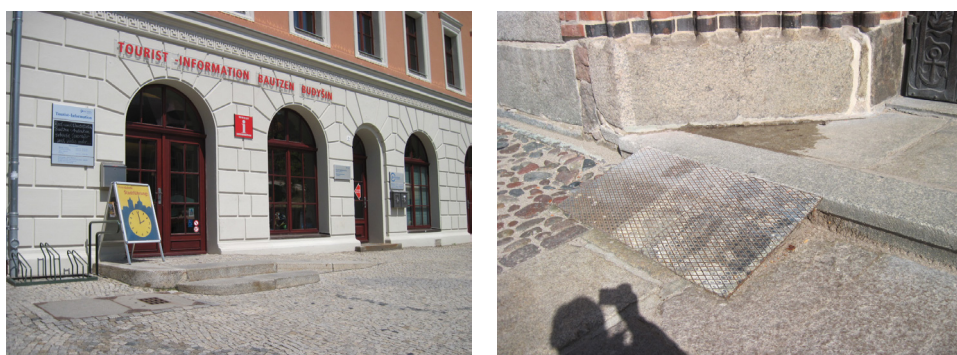
Ryc. 3 Pochylnia wkomponowana w otoczenie obiektu zabytkowego oraz tymczasowa pochylnia stalowa (fot. autor)
