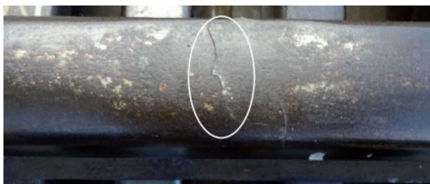
Rys. 3. Pęknięcie powierzchniowe szyny typu squat [fot. I. Mikłaszewicz]
