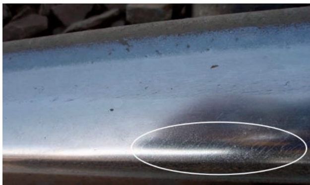
Rys. 1. Pęknięcia krawędziowe szyny na etapie początkowym [fot. I. Mikłaszewicz]
