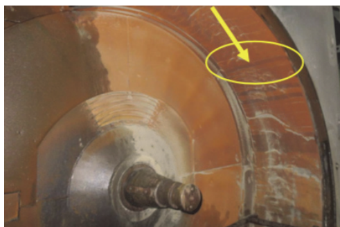
Rys. 3. Płaskownik obwodowy młyna MWk16 (opracowanie własne) Fig. 3. MWk16 coal mill peripheral flat bar (own study)
