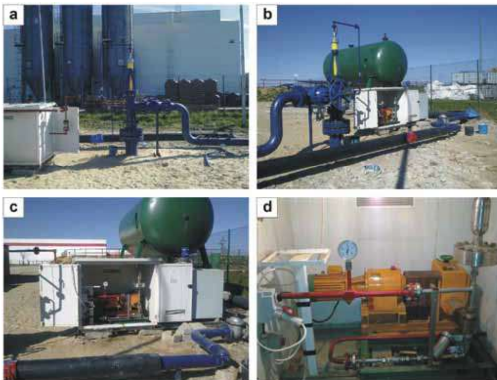
Rys. 2. Instalacja systemu geotermalnego Skierniewice GT-1 – Skierniewice GT-2; uzbrojenie głowicy otworu Skierniewice GT-2 (a, b) oraz aparatura do dozowania cieczy kwasującej (c, d) (fot. B. Bielec, na podstawie [1])
