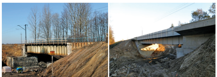
Rys. 10. Wiadukt kolejowy przed i po modernizacji, obejmującej całkowitą wymianę konstrukcji stalowej przęśta
