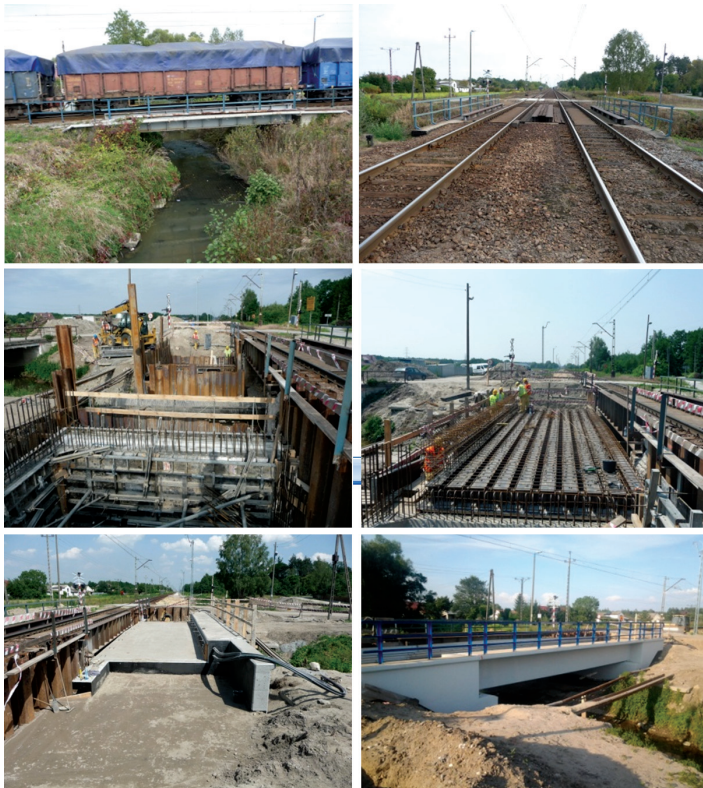
Rys. 7. Przebudowa małego mostu stalowego z wykorzystaniem nowego przęśta z dźwigarów obetonowanych
