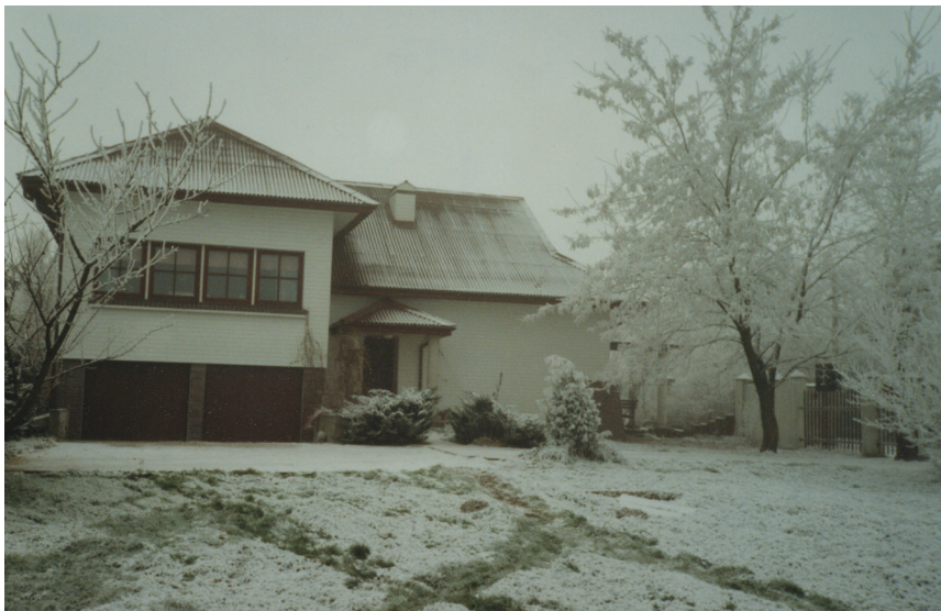
Rys. 6. Dom PD2 po I modernizacji – zdjęcie r. 1997 (źródło: archiwum autora)
