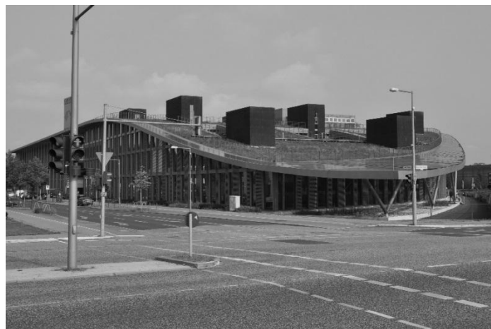
Rys. 2. Budynek SOLON w Berlinie, proj. SFA Schulte-FrohlindeArchitekten, 2008 (fotografia autorki)
