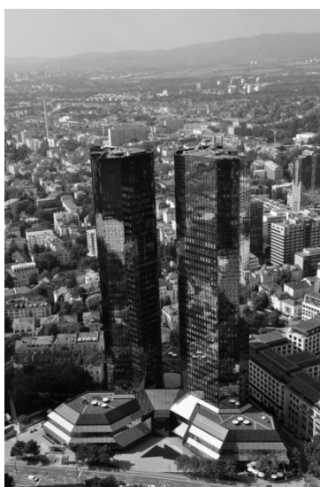
Rys. 9. Siedziba Deutsche Bank we Frankfurcie nad Menem, budynek – proj. Walter Hanig, Heinz Scheid, Johannes Schmidt, 1984; przebudowa – proj. MBA Mario Bellini Architects S.r.l, gmpArchitekten von Gerkm, 2011 (fotografia własna)
