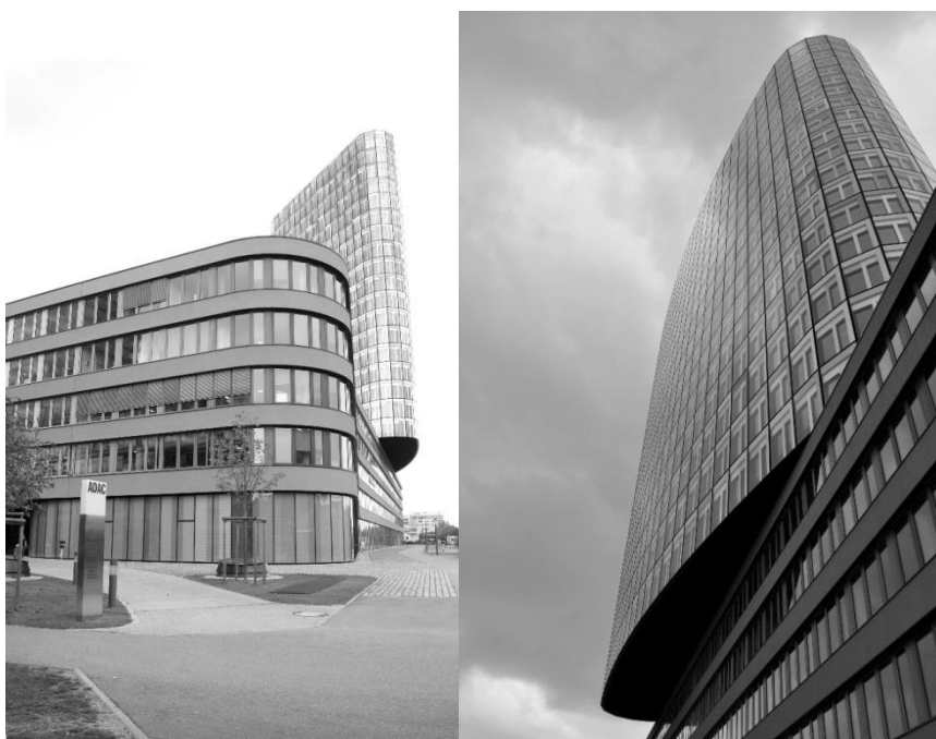
Rys. 5. Budynek ADAC w Monachium, proj. Sauerbruch-Hutton, 2012 (fotografia autorki)
