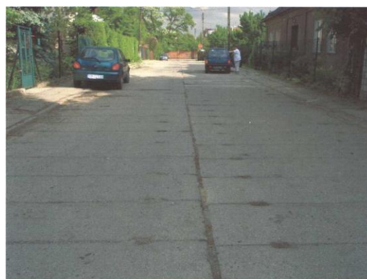
Rys. 24. Droga z płyt betonowych
