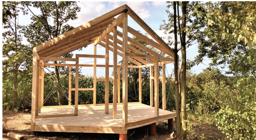
Fot. 2. Kompletny szkielet konstrukcyjny pierwszej kabiny. Fot. E. Rdzawska-Augustin, wrzesień 2019
