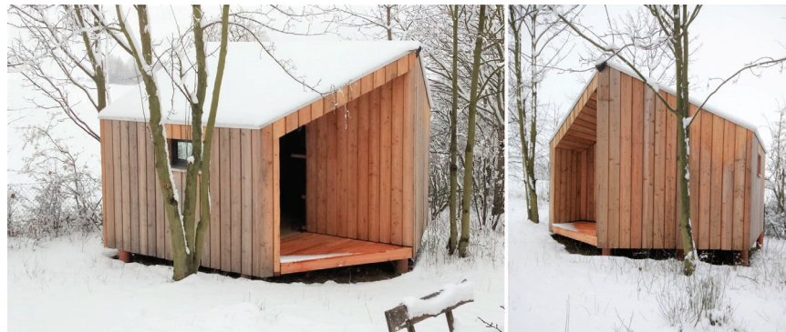
Fot. 3. Efekt końcowy – gotowa kabina mieszkalna. Fot. A. Freckmann, styczeń 2021
