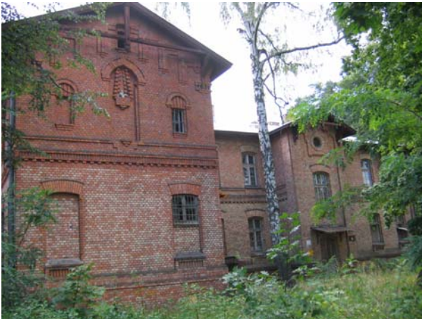
Ryc. 2. Widok elewacji północno-wschodniej Fig. 2. The north-east view of the building's façade
