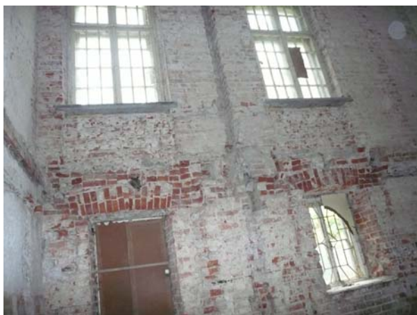
Ryc. 6. Ściana nadziemia, mur ceglany na zaprawie wapiennej Fig. 6. Wall above ground level – brick with lime mortar
