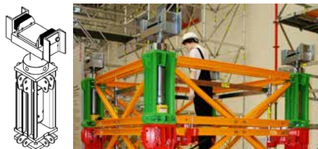
Ryc. 6. Głowica VST 100. Na zdjęciu widoczne są siłowniki hydrauliczne zamontowane w głowicach
