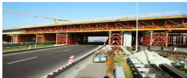
Ryc. 20. Widok rusztowania podporowego nad jezdniami autostrady A1
