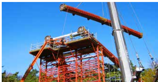
Ryc. 24. Wieża podporowa PERI VST o rozbudowanej konstrukcji i z systemem roboczym z elementów systemu PERI VARIOKIT
