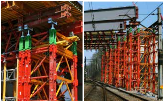
Ryc. 9. Wieże podporowe PERI VST wzmocnione ze stężeniami z łączników poziomych VST (z lewej) lub wypór wysokonośnych SLS
