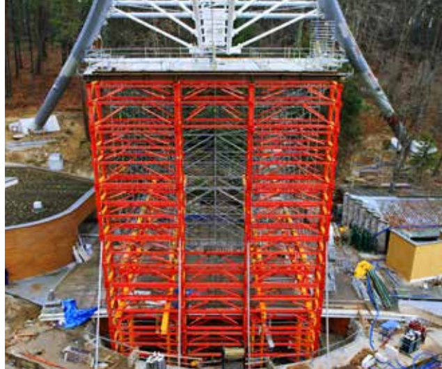
Ryc. 23. Widok rusztowania podporowego
