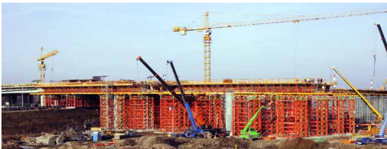
Ryc. 21. Widok rusztowania podporowego poza nasypem autostrady A1 (wieże o wysokości do 13,0 m)
