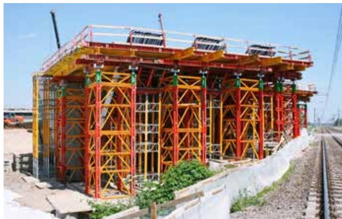
Ryc. 16. Widok rusztowań podporowych wiaduku WA122 przed ułożeniem dźwigarów T24
