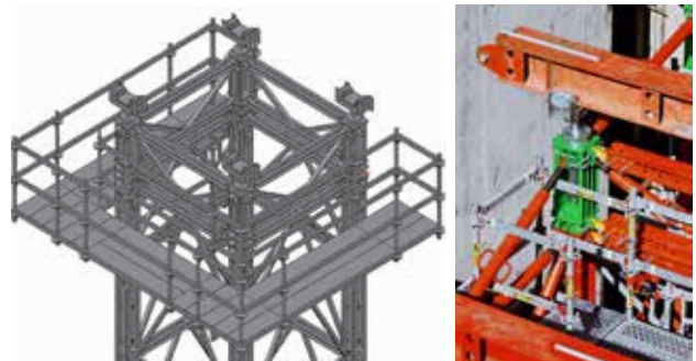
Ryc. 11. Pomost roboczy w systemie PERI Up Rosett do obsługi głowic VST 100
