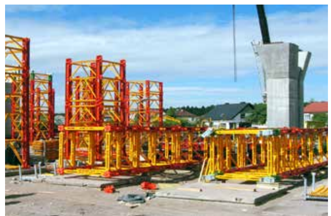
Ryc. 13. Widok wież podporowych PERI VST montowanych w poziomie
