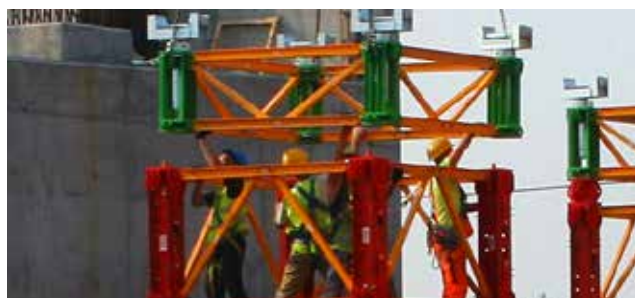
Ryc. 7. Montaż kompletnego modułu głowicowego VST 100. Widoczne są wtyki łączników dolnego modułu
