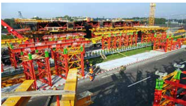
Ryc. 18. Montaż wież PERI VST rusztowania podporowego nad jezdniami autostrady A1
