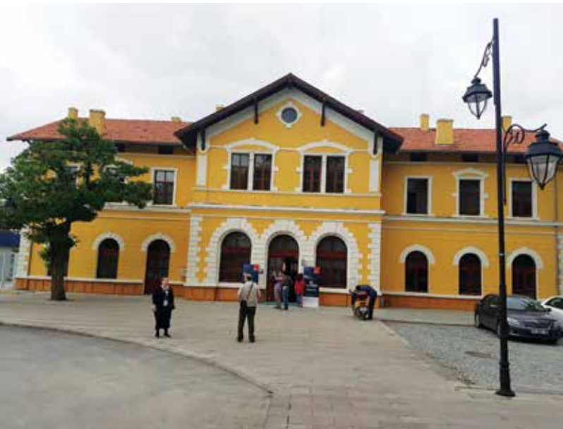
Zabytkowy budynek dworca w Konyi
