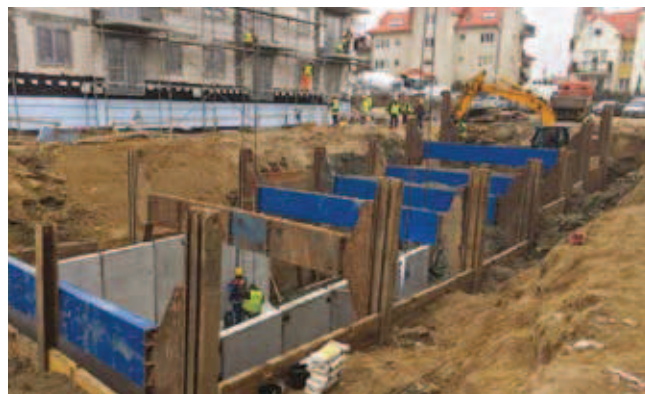
Rys. 10. Fragment montażu elementów prefabrykowanych zbiornika
