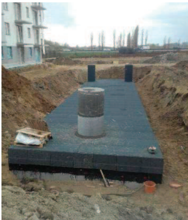
Rys. 13. Efekt końcowy realizacji zbiornika retencyjnego
