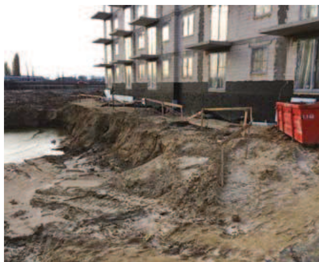
Rys. 4. Widok placu budowy przed rozpoczęciem prac
