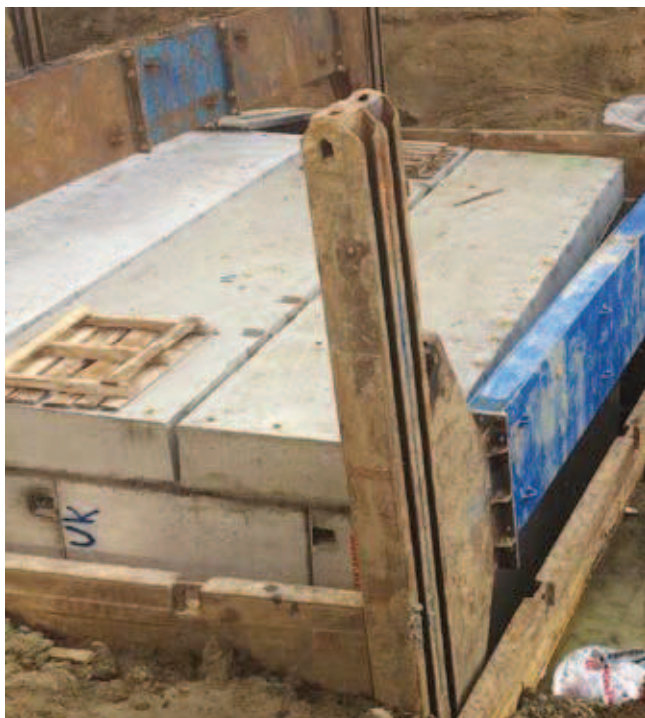
Rys. 12. Fragment montażu płyt przekrywających zbiornik
