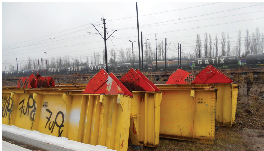
Rysunek 2. Elementy pasa dolnego kratownicy przęsła mostu ułożone na placu składowym
