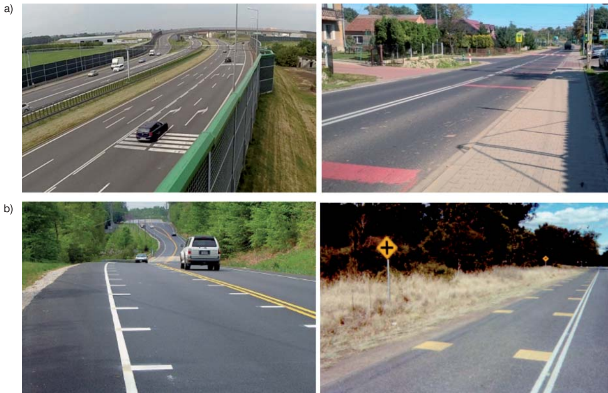
Fot. 1. Pasy na jezdni: a) spotykane w praktyce krajowej pasy przez całą szerokość pasów ruchu w rejonie węzła drogowego i przed przejściem dla pieszych (źródło: Politechnika Krakowska); b) stosowane w praktyce zagranicznej poprzeczne pasy krawężniowe białe [1] i żółte [16]
