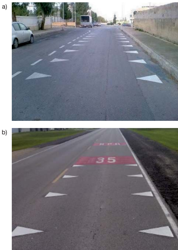
Fot. 2. Znaki trójkątne na jezdni: a) na dojeździe do skrzyżowania [24], b) w połączeniu ze znakiem ograniczenia prędkości na jezdni [12]
