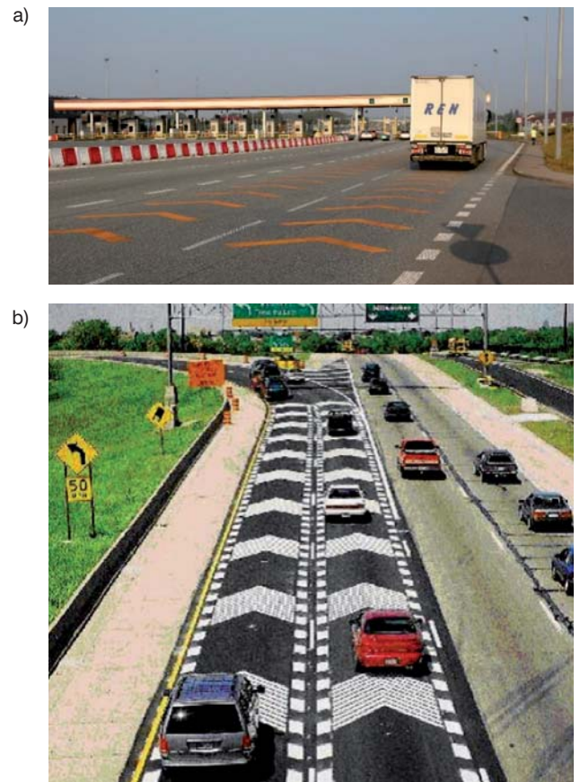
Fot. 3. Oznakowanie w kształcie litery V: a) w Polsce na dojeździe do bramek punktów poboru opłat (źródło: IBDiM, INOS); b) w USA na dojeździe do łącznicy węzła drogowego [9]
