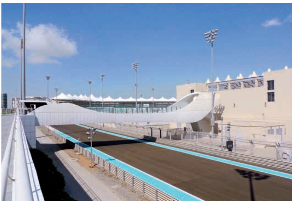
Kładka pieszo-jezdna nad fragmentem toru, fot. K. Ryż
