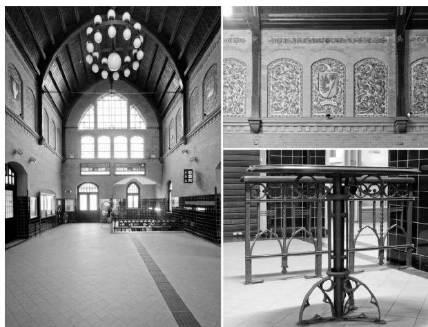
Rys. 6. Iława Główna, detale holu głównego, 2019 [fot. autorka]
