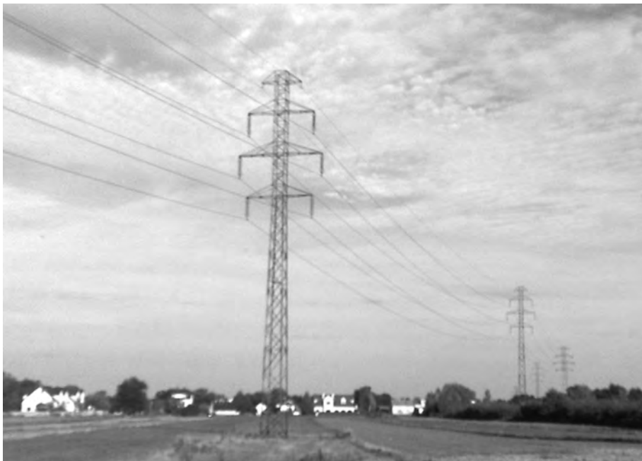
Rys. 32a. Widok linii energetycznej wykorzystanej w testach radaru (wskazania radaru – patrz rys. 33÷36)
