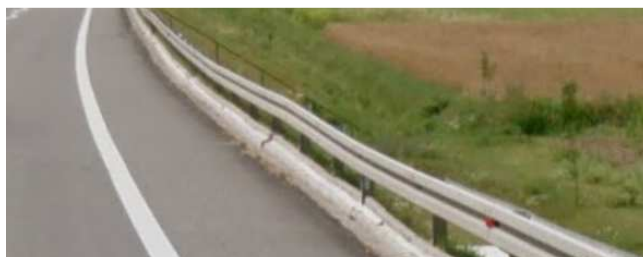
Rys. 4. Widok drogi nad obiektem. Źródło: www.google.maps.com
