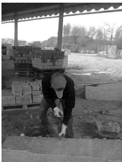
Rys. 3. Praca młotem pneumatycznym
