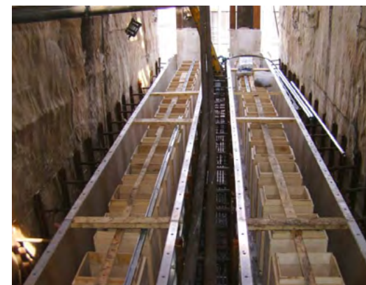
Rys. 4. Przygotowane i zamontowane formy służące odbudowie ścian grzewczych
