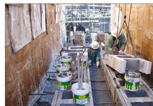
Rys. 6. Odbudowa ścian grzewczych za pomocą technologii modułowej
