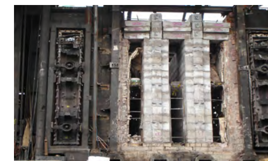
Rys. 7. Odbudowane ściany grzewcze z użyciem technologii modułowej
