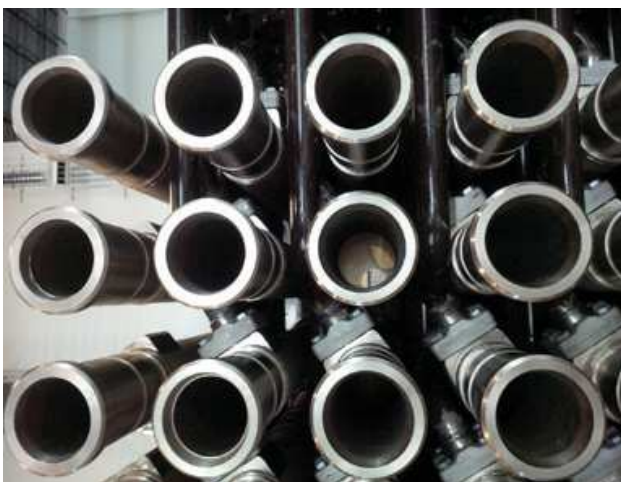
Fot. 4. Końcówki kanałów Photo 4. Reactor channel end fittings
