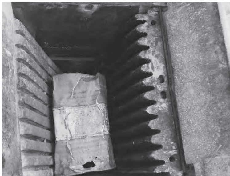
Fig. 2. General view of the newly installed fixed jaw on the first day of service (to the right) Rys. 2. Widok ogólny nowo zamontowanej szczęki stałej w pierwszym dniu eksploatacji (z prawej)
