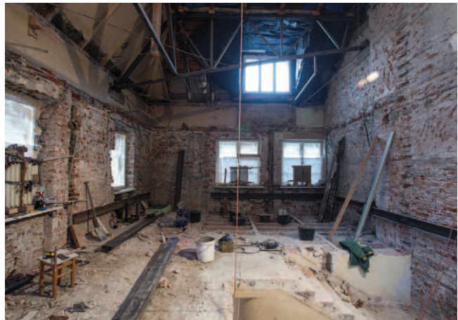
Rys. 2. Zdjęcie z realizacji opisanego wzmocnienia więźby dachowej (fotografia własna)
