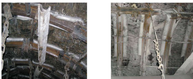
Fot. 1. Widok przykotwionych luków stropowych oraz wykładki mechanicznej Photo 1. A view of bolted roof arches and mechanical lining
