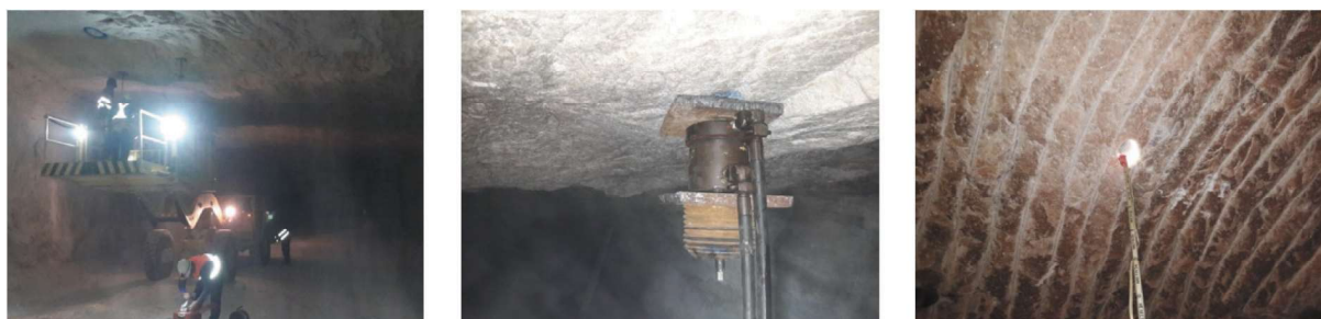
Fot. 5. Test obciążeniowo-odkształceniowy kotew w KS Kłodawa; a) komora eksploatacyjna, b) etap obciążania, c) ocena ciągłości górotworu kamerą Photo 5. Load – displacement test of rock bolt support at Kłodawa Salt Mine; a) exploitation chamber, b) loading stage, c) assessment of rock mass continuity by means of camera
