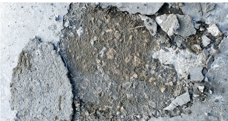
Fot. 6. Widok powierzchni betonu w miejscu odspojenia wierzchniej utwardzonej warstwy – wyraźny brak ciągłości struktury materiału
