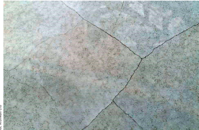
Fot. 1. Charakterystyczne spękania odpajającej się wierzchniej warstwy płyty betonowej
