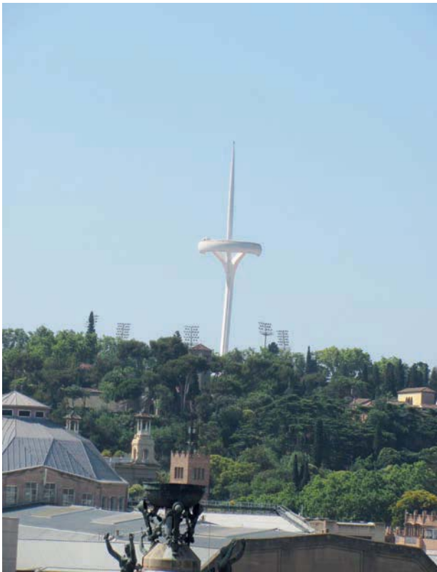
Il. 15. Delikatna, biała rzeźbiarska forma wieży telekomunikacyjnej na Montjuïc zdaje się dematerializować na tle nieba – fot. autor
