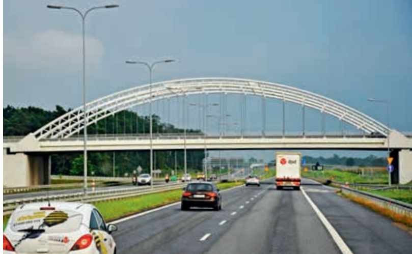
Stalowy wiadukt nad autostradą A1 na trasie Toruń – Włocławek (obiekt nr 69)
