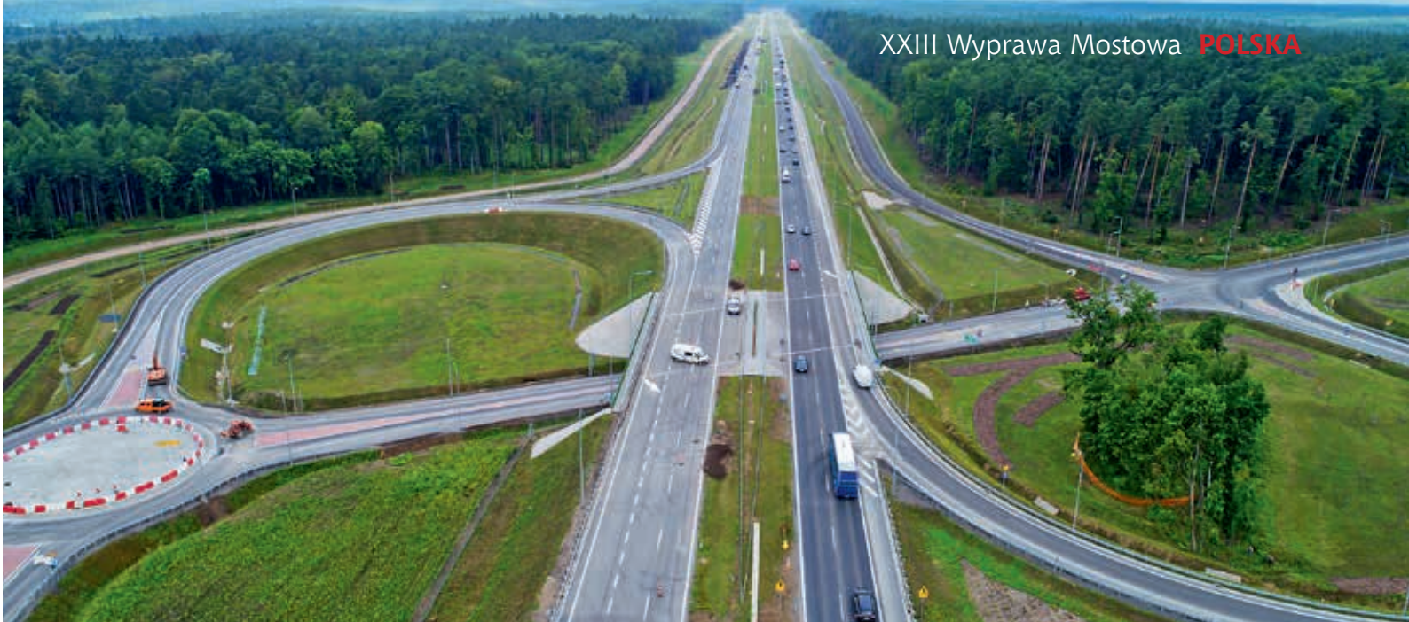
Węzeł Ostróda Północ z wiaduktem WD-1
