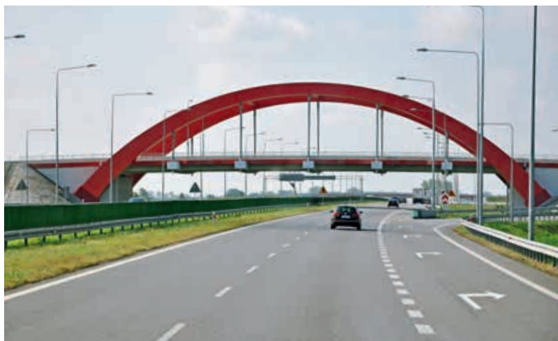
Stalowy wiadukt łukowy nad autostradą A1 (obiekt nr 72)
