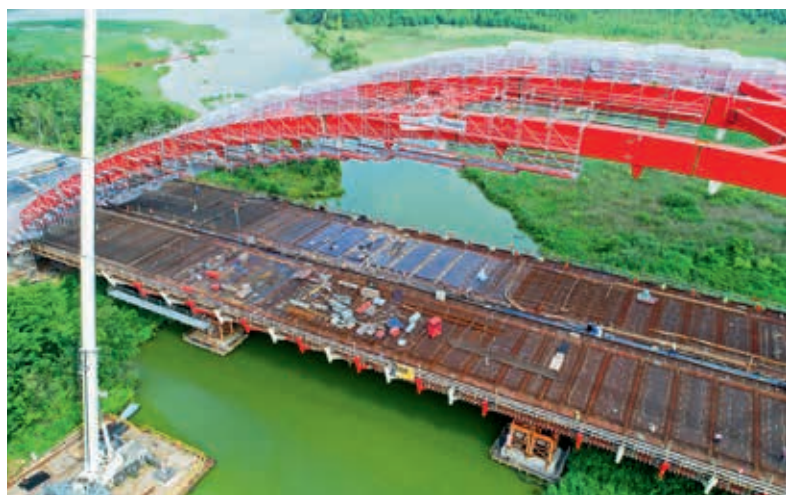
Most MS-4, widok pomostu w trakcie prac zbrojarskich
