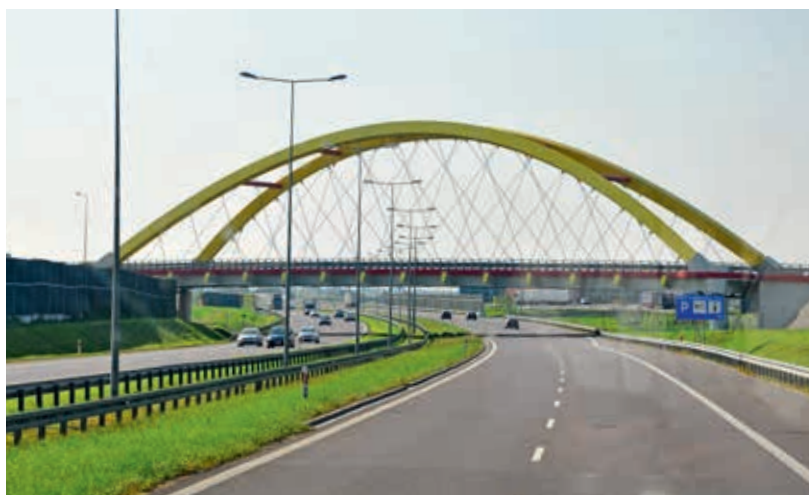
Stalowy wiadukt łukowy nad autostradą A1 (obiekt nr 70)
