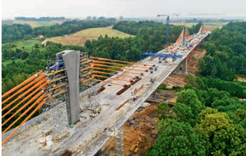
Most MS-3/DK16, widok pylonów P4, P3, P2 oraz pomostu
