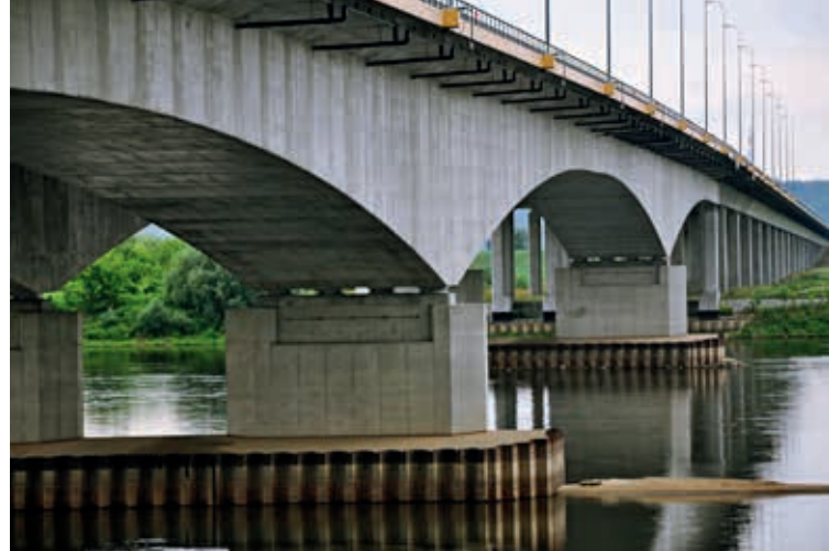
Betonowy most autostradowy przez Wisłę w Grudziądzu ( l_{\max} = 180 m) – obiekt nr 66
