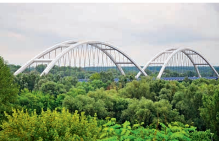
Stalowy most łukowy przez Wisłę w Toruniu ( l_{\max} = 2 \times 270 \text{ m} ) – obiekt nr 68
