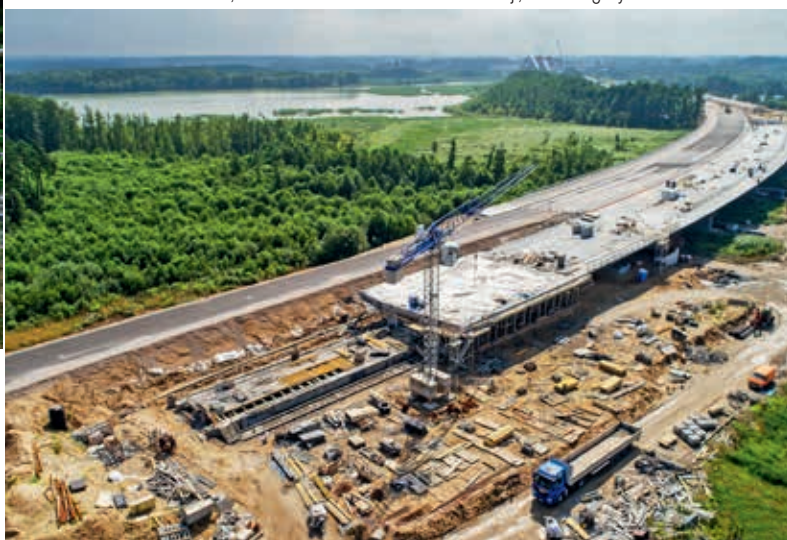
Most MS-2, stanowisko betonowania konstrukcji, widok z góry
