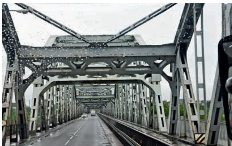
Szczegóły mostu nr 63 przez Wisłę w Grudziądzu
