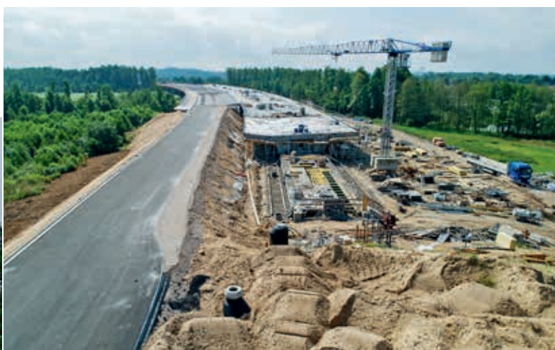
Most MS-2, stanowisko betonowania konstrukcji, widok na oś drogi
