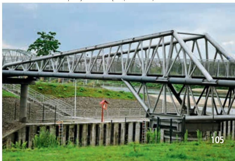
Kratownicowa kładka dla pieszych w Grudziądzu (obiekt nr 65)
