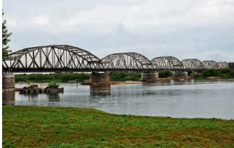
Poniemiecki most kolejowo-drogowy przez Wisłę w Grudziądzu (obiekt nr 63)
