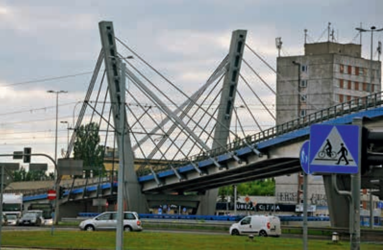
Podwieszona stalowa estakada zakrzywiona w planie w Toruniu (obiekt nr 67)
