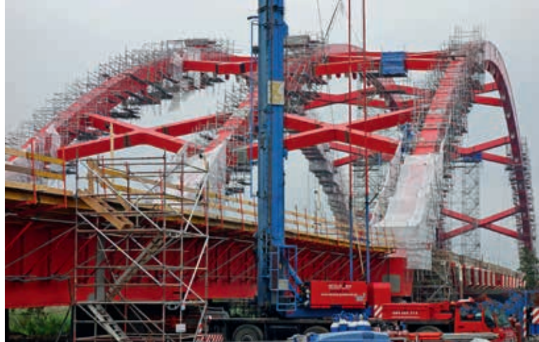
Most MS-4, widok konstrukcji w czasie prac antykorozyjnych (obiekt nr 59)
