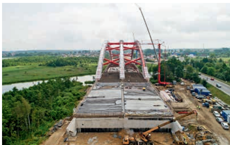
Most MS-4, widok zabetonowanego przęsła skrajnego
