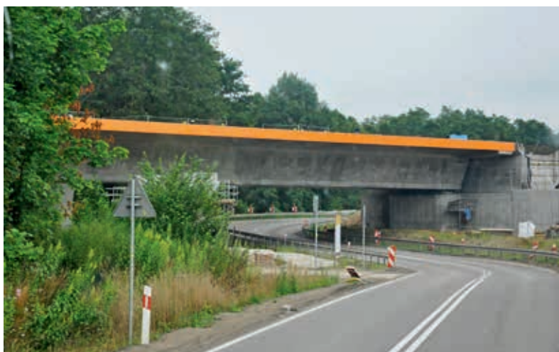
Betonowy sprężony wiadukt na obwodnicy Ostródy (obiekt nr 58)
