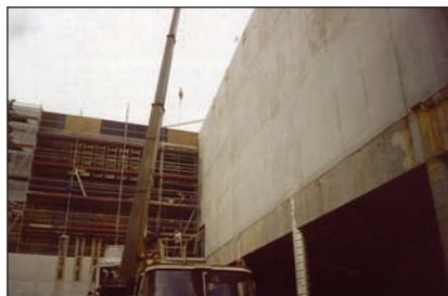
Fot. 3. Superkino w Gdańsku – z lewej strony szalowanie ściany, z prawej gotowa ściana wykonana z SCC
