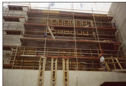
Fot. 1. Superkino w Gdańsku – szalowanie ściany do zabudowy SCC (wysokość: ok. 8 m, szerokość ok. 8 m, grubość 25 cm); ściana zbrojona z otworami w środku
