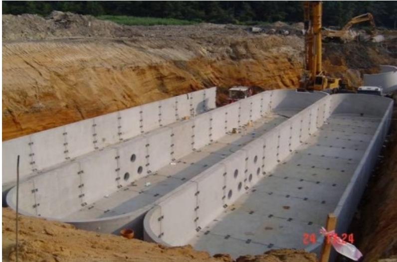
Rys. 3. Zbiornik retencyjny w trakcie budowy [9].
