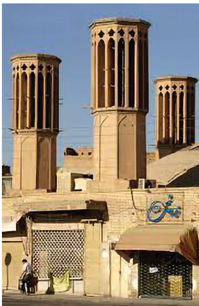
Fot. 5. Tradycyjna wieża wiatrowa; źródło: [15]
