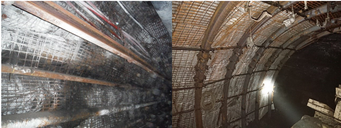
Rys. 15.2 Tradycyjny i zmodyfikowany sposób uszczelnienia ociosu płotu węglowego
