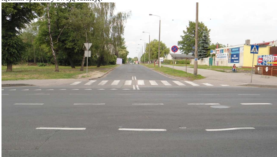
Fot. 1 Wjazd na łącznik od strony ul. Dworcowej
