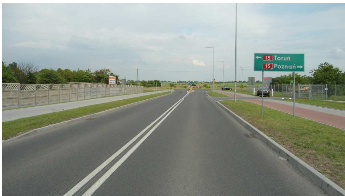
Fot. 3 Wyjazd z łącznika od strony ul. Toruńskiej
