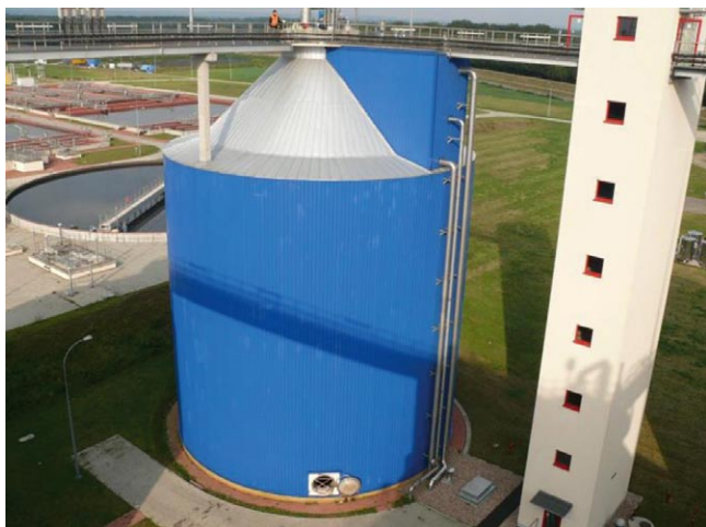
Rys. 1. Wydzielona komora fermentacyjna z widocznym słupem podporowym zakotwionym w ścianie zbiornika (zdjęcia autorów)
