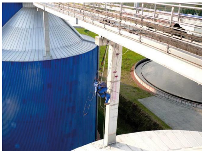
Rys. 3. Badanie zarysowania słupa podporującego pomost komunikacyjny (zdjęcia autorów)
