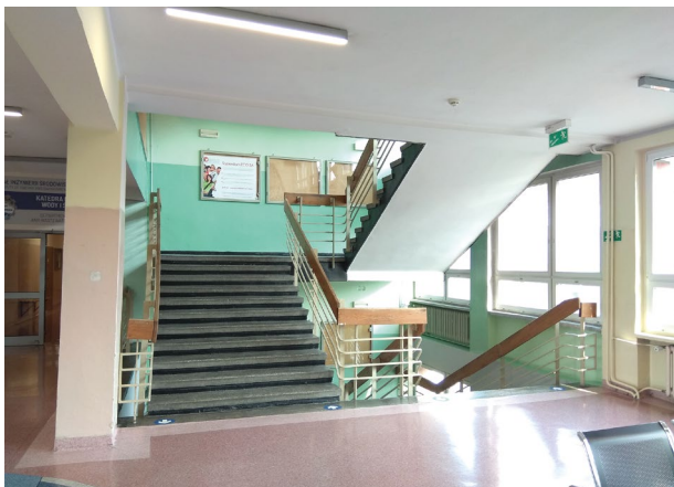
Figure 9. Staircase K2 Rycina 9. Klatka schodowa K2 Source: Own elaboration. Źródło: Opracowanie własne.
