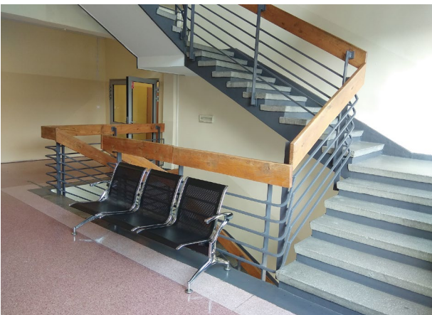
Figure 5. Staircase K1 Rycina 5. Klatka schodowa K1
