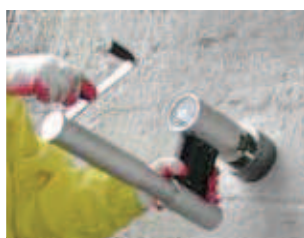
Rys. 3. Badanie przyczepności metodą pull-off (fot. D. Borkowski)
