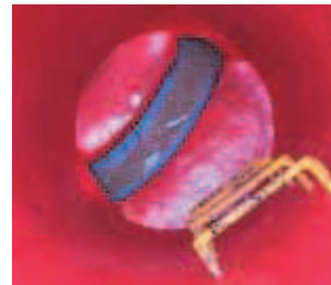
Rys. 5. Studzienka po renowacji polimocznikiem (fot. D. Borkowski)
