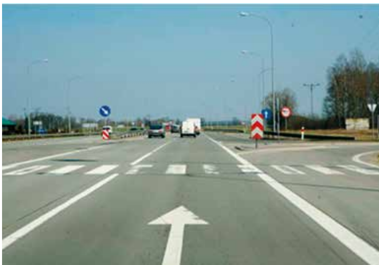
Fot. 10. Widok warstwy ścieralnej whitetopping z betonu cementowego na odcinku Wolbórz – Polichno po 12 latach eksploatacji widoczny poniżej. Fot. Stowarzyszenie Producentów Cementu (SPC)
