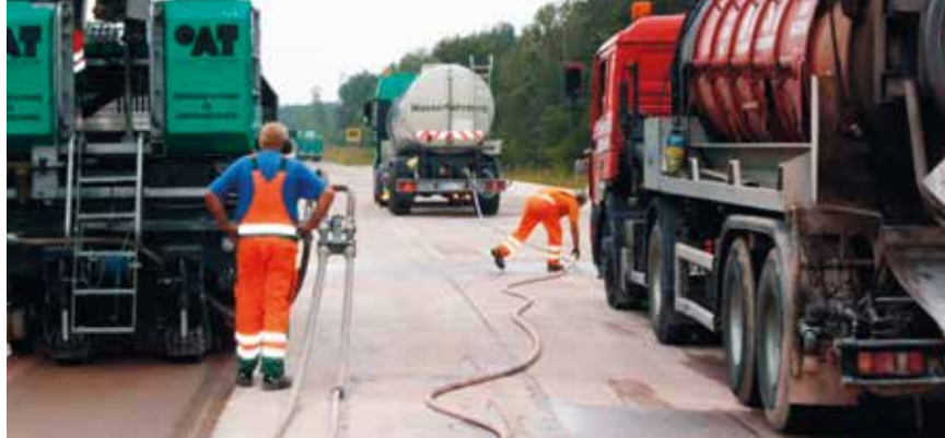
Fot. 13. Typowy zestaw maszyn do teksturowania nawierzchni z betonu cementowego metodą „grinding”. Fot. Otto Alte-Teigeler GmbH
