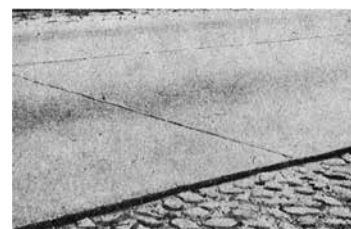
Fot. 3. Widok nawierzchni z betonu cementowego na drodze Warszawa – Białystok, odcinek Radzymin – Wyszków po 46 latach eksploatacji [4]. Źródło: Stefan Rolla, Nowoczesne nawierzchnie betonowe, WKŁ 1983, str. 20
