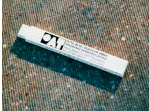
Fot. 14. Efekt teksturowania nawierzchni z betonu cementowego metodą „grinding”. Fot. Otto Alte-Teigeler GmbH
