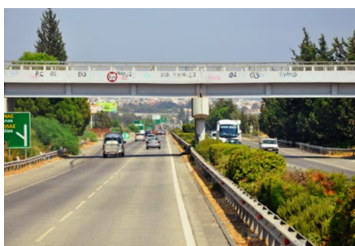
Typowy betonowy obiekt mostowy nad autostradą w okolicy Limassol (obiekt nr 7)
