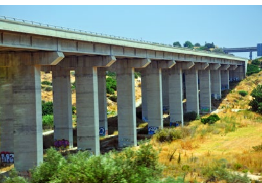
Betonowy obiekt mostowy na trasie Kourion – Omodos (obiekt nr 6)
