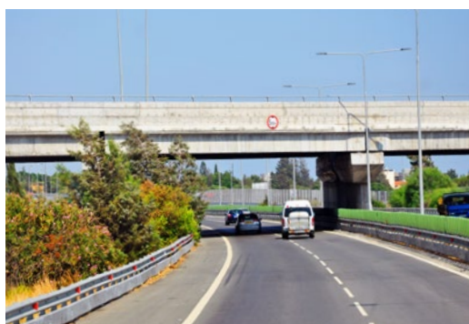
Typowy betonowy obiekt mostowy nad autostradą w okolicy Limassol (obiekt nr 8)
