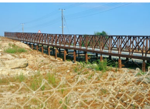
Drewniany mostek dla pieszych prowadzący do wykopalisk w Amathus (obiekt nr 9)
