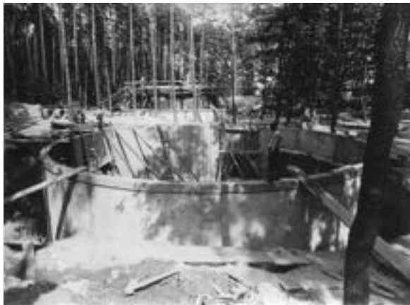
Rys. 1. Budowa Wytwórni i Bazy Magazynowej Państwowego Monopolu Spirytusowego w ramach COP [1]
