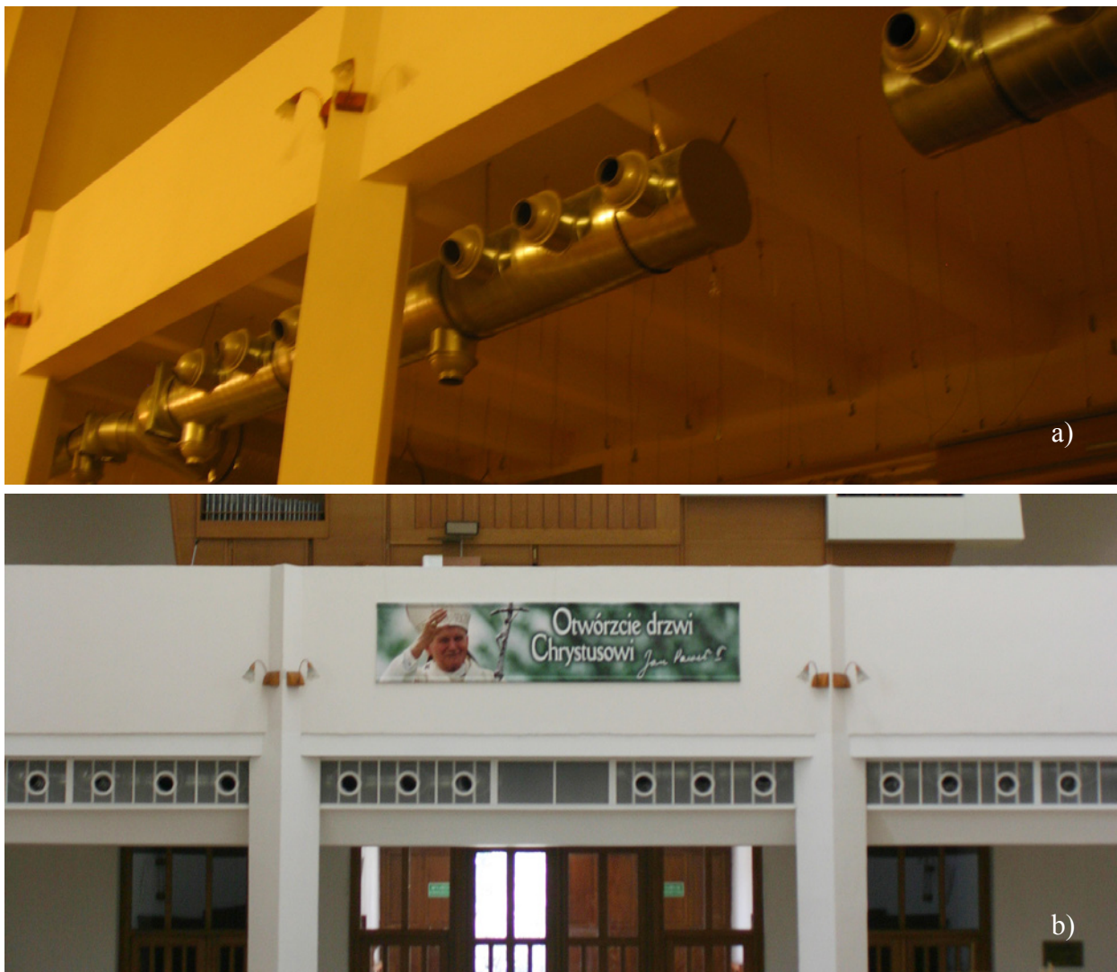
Rys. 22 a. b. System wentylacji (wymiany powietrza), nad głównym wejściem do kościoła; źródło: fot. archiwum J. Wrana
