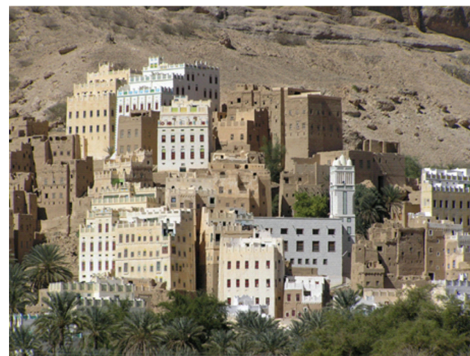
Il. 5. Gliniane miasto Shibam w Jemenie. źródło: www.skyscrapercity.net (dość: 20 listopada 2017)/ The clay city of Shibam, Yemen. source: www.skyscrapercity.net (retrieved on: 20th of November 2017)
