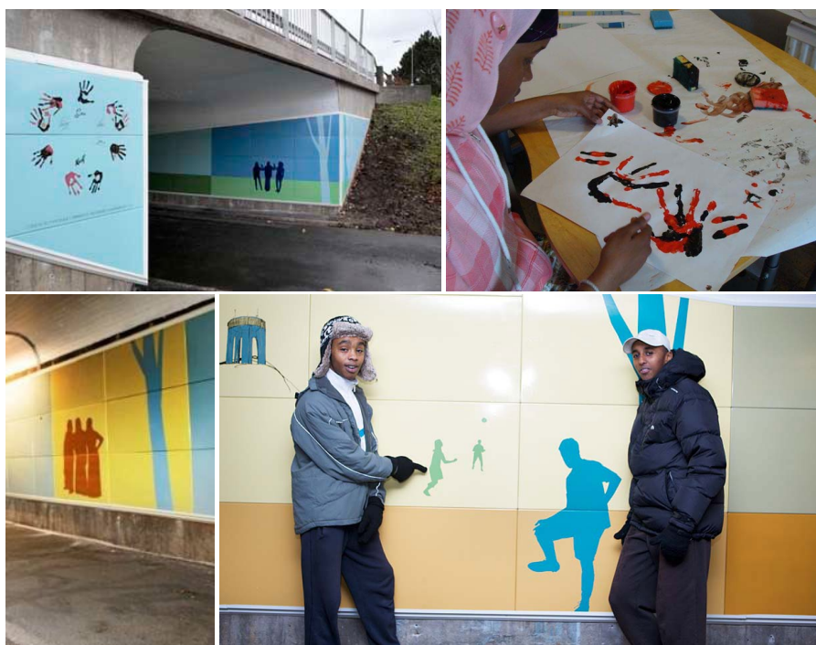
Ryc. 2. Fragment zmodernizowanego tunelu dla pieszych (fot. M. Zienowicz)
