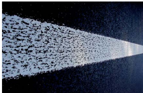
Fot. 6. Oznakowanie poziome grubowarstwowe z masy chemoutwardzalnej – strukturalne nieregularne
