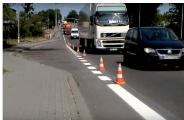
Fot. 20. Nawierzchnia przed aplikacją natryskowej masy termoplastycznej i po aplikacji
