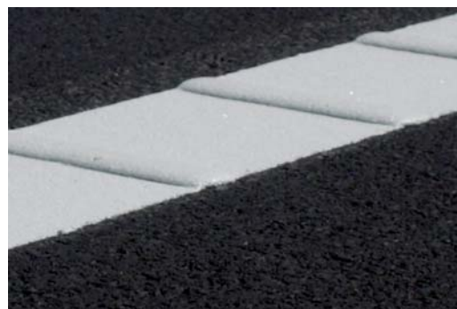
Fot. 11. Oznakowanie poziome grubowarstwowo z masy termoplastycznej – akustyczne (beretka z taśmą bazową)
