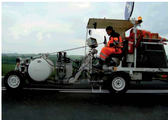
Fot. 2. Maszyny do wykonywania oznakowania cienkowarstwowego
