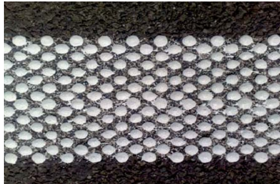
Fot. 5. Oznakowanie poziome grubowarstwowe z masy chemoutwardzalnej – strukturalne regularne
