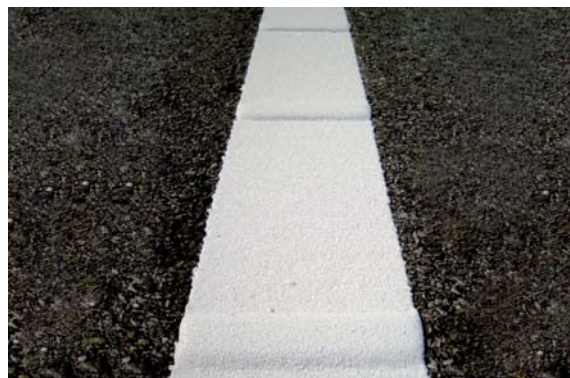
Fot. 7. Oznakowanie poziome grubowarstwowe z masy chemoutwardzalnej – akustyczne (beretka)
