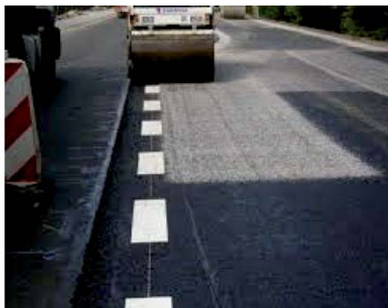
Fot. 15. Wykonywanie oznakowania grubowarstwowego z taśm prefabrykowanych na świeżej nawierzchni ścieralnej
