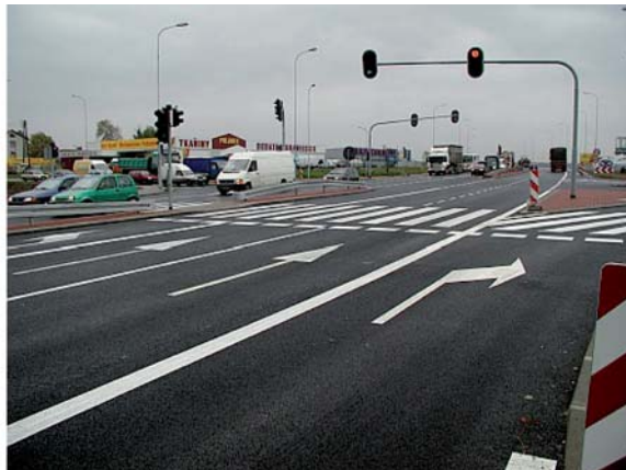
Fot. 22. Nawierzchnia przed aplikacją natryskowej masy STAMARK LPM 1200 i po aplikacji
