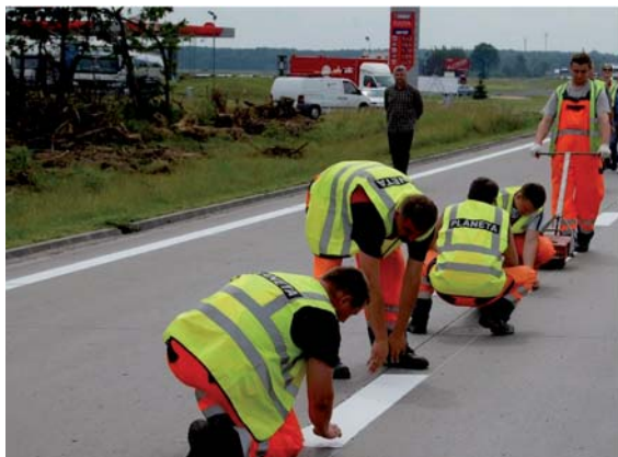
Fot. 14. Wykonywanie oznakowania grubowarstwowego z taśm prefabrykowanych
