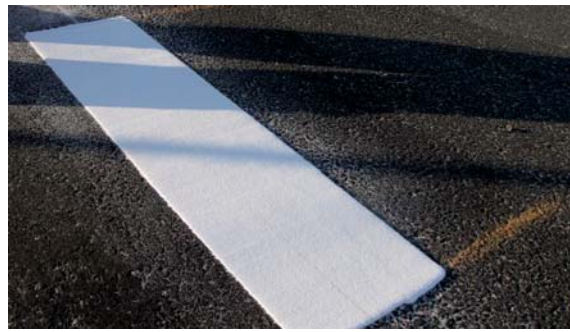
Fot. 4. Oznakowanie poziome grubowarstwowe z masy chemoutwardzalnej – gładkie
