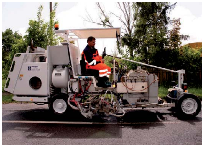
Fot. 21. Specjalistyczna maszyna do renowacji oznakowania poziomego spray termo
