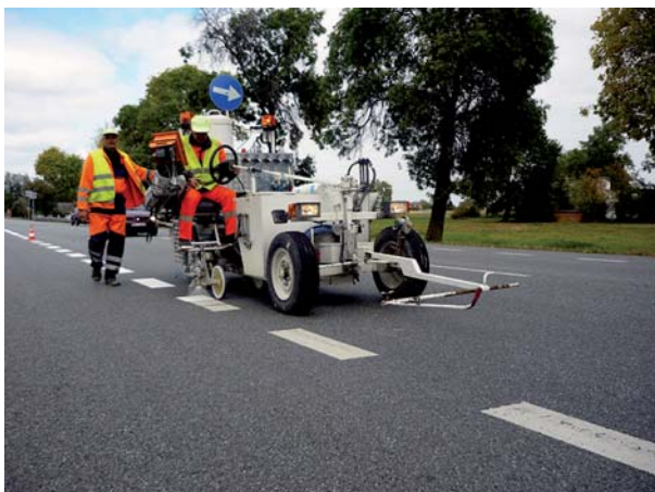
Fot. 16. Aplikacja natryskowej masy chemoutwardzalnej plastirok spray
