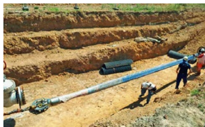
Ryc. 2. Powłoka Primus Line przygotowana do wciągnięcia do rurociągu [3]
