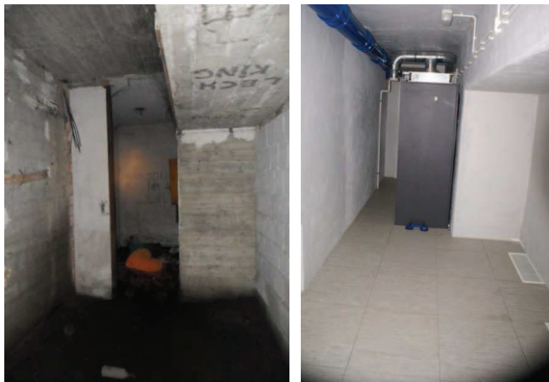
Fot. 7 i 8. Pomieszczenie gospodarcze przed i po remoncie
