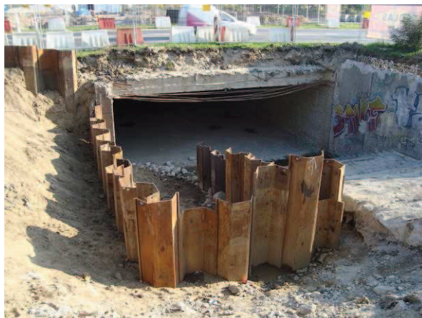
Fot. 4. Ścianki szczelne- zabezpieczenie wykopów i deskowanie tracone szczelnej „wanny” żelbetowej
