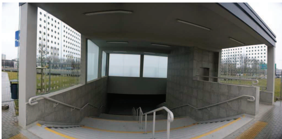
Fot. 10. Wejścia do tunelu – zadaszenie i biegi schodowe
