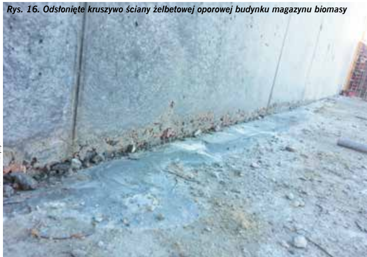
Rys. 16. Odsonięte kruszywo ściany żelbetonowej oporowej budynku magazynu biomasy
