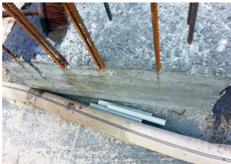
Rys. 1b. Brak zachowania wymaganej otuliny betonu prętów zbrojeniowych startowych ścian fundamentowych. Widok ławy fundamentowej. Budynek elektrociepłowni
