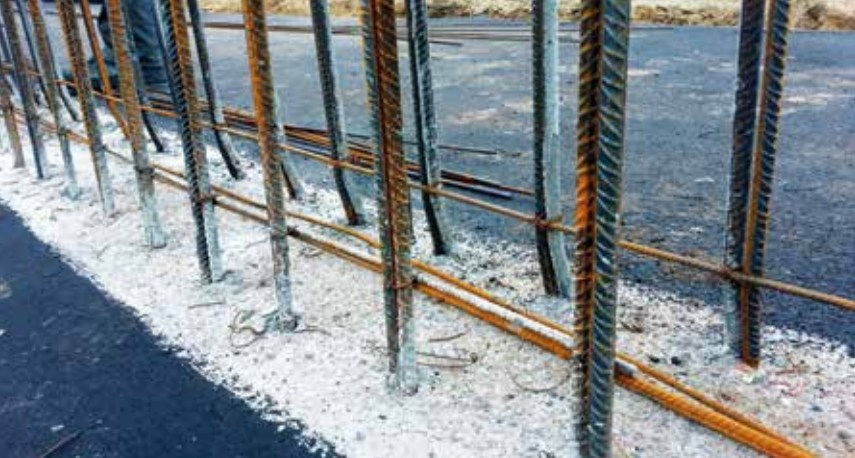
Rys. 8a. Brak zachowania wymaganego rozstawu poprzecznego prętów zbrojeniowych startowych - ściana oporowa. Budynek magazynu biomasy
