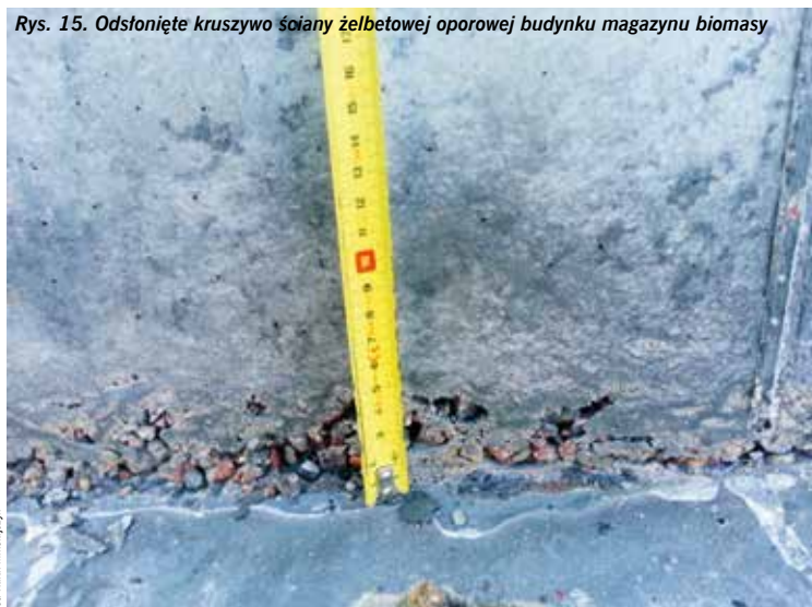
Rys. 16. Odsonięte kruszywo ściany żelbetonowej oporowej budynku magazynu biomasy
