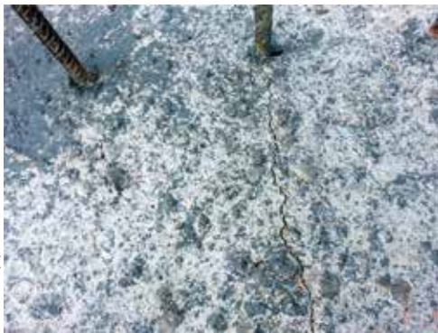
Rys. 4. Zarysowanie ławy fundamentowej (wykonanej po długości) w górnej jej części. Budynek elektrociepłowni
