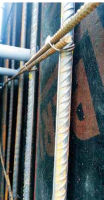
Rys. 1a. Brak zachowania wymaganej otuliny prętów zbrojeniowych ściany oporowej. Widok ze środka deskowania. Budynek magazynu biomasy
