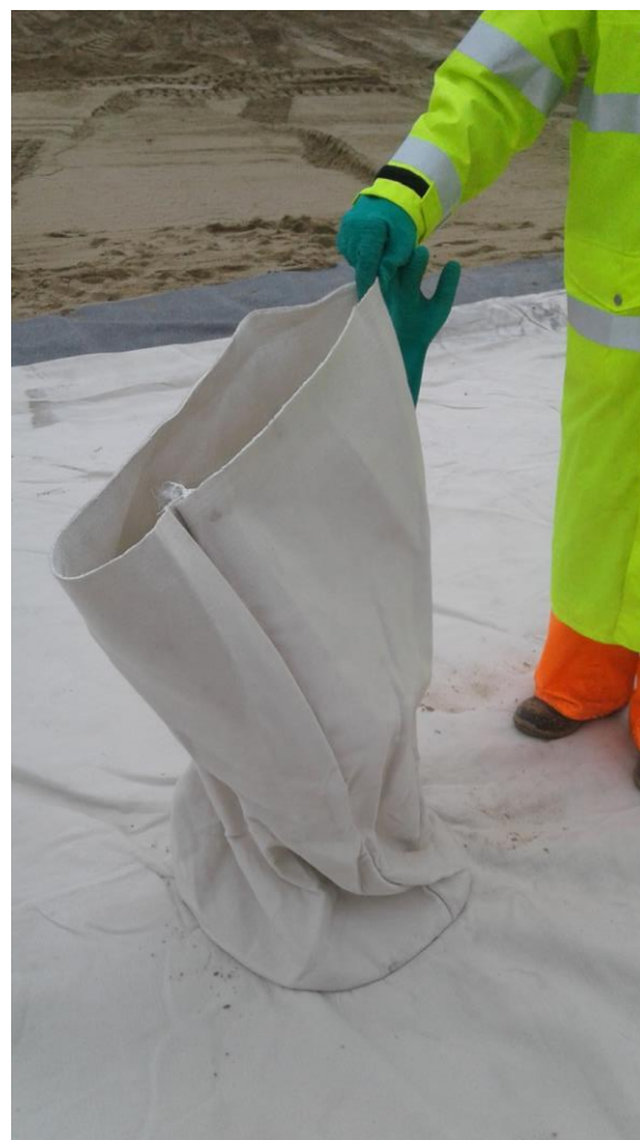
Rys. 2. Kominek do napełniania georury (fot. B. Smoliński)
