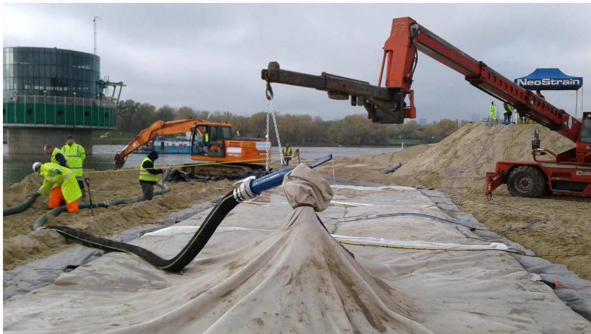
Rys. 3. Napełnianie georury. Widoczny rurociąg tłoczny z głowicą podłączoną do kominka (fot. B. Smoliński)
