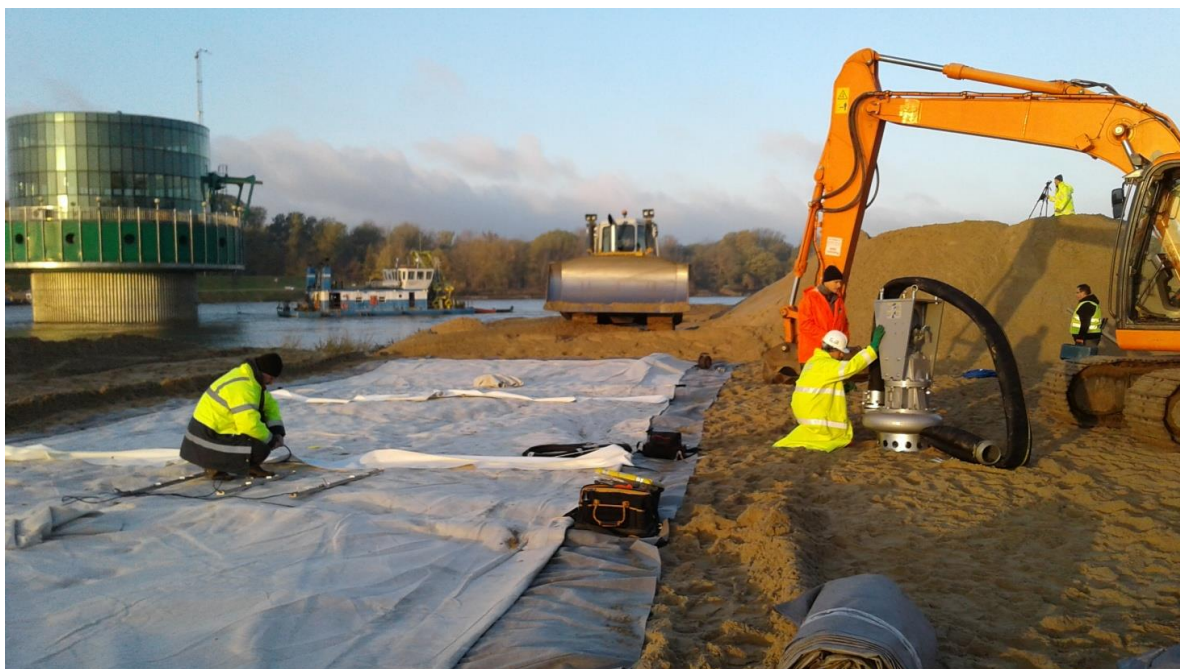
Rys. 1. Przygotowanie platformy roboczej. Widoczna pompa bagrowa (fot. B. Smoliński)
