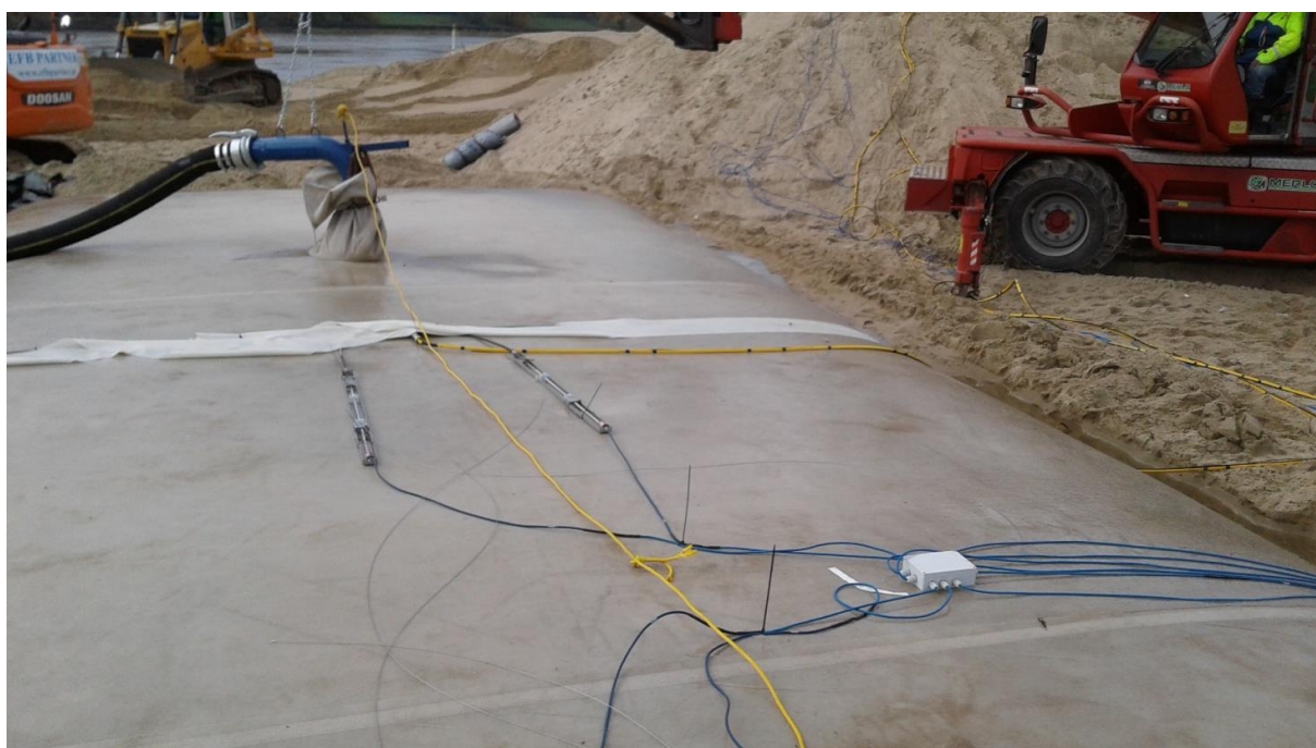
Rys. 6. Napełnianie georury. Widoczne czujniki pomiarowe zamontowane na płaszczu (fot. B. Smoliński)
