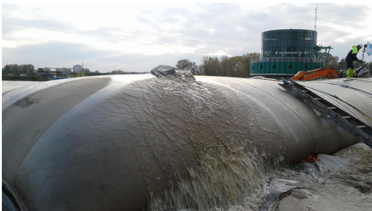
Rys. 4. Napełnianie georury. Widoczny wypływ refulatu z kominka (fot. B. Smoliński)
