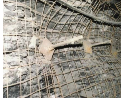
Rys. 6. Widok przylegającej podkładki do ociosu, kotwi z gwintem na całej długości
