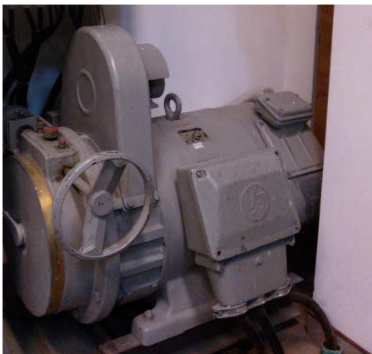
Rys. 8. Regulator indukcyjny MEZ VSETIN BP 94-2
